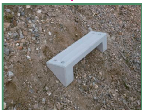
④打ち込み完了
