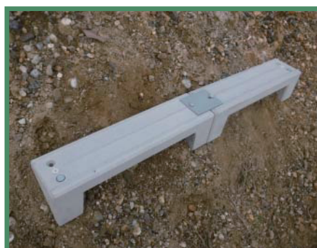
法面ステップ連結完了
