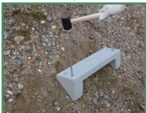
③杭を穴に挿しハンマー等で打ち込む
