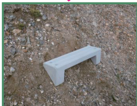
②法面ステップを斜面に置きます。
