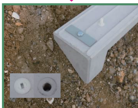
⑥インサートキャップを外しプレートをボルトで固定 (杭の浮き上がりを抑止します) 完成!
