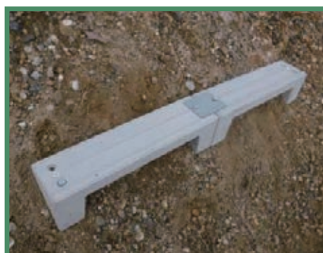
法面ステップ連結完了
