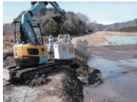
バックホウでの施工が可能
