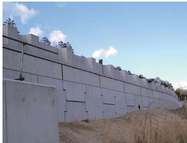
補強土壁直上設置の事例
