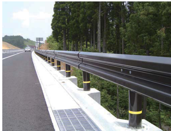
背面に側溝設置の事例
