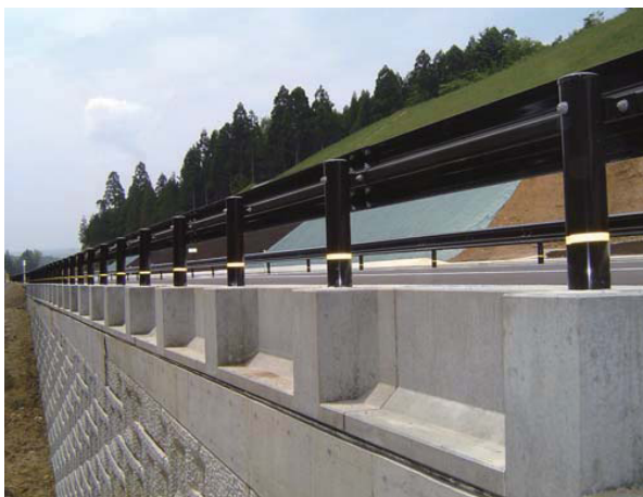
補強土壁直上設置の事例
