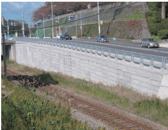
超軽量盛土直上設置の事例
