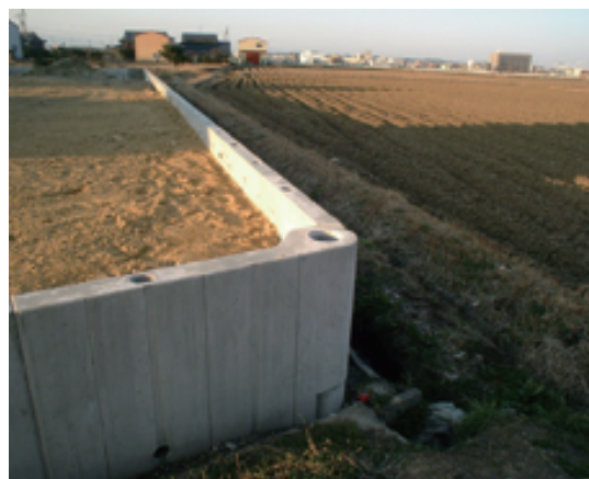
⑥設置完了
