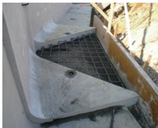
⑤底板現場打配筋状況
