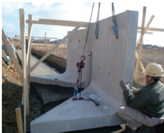
③フリーコーナー (A) 設置状況
