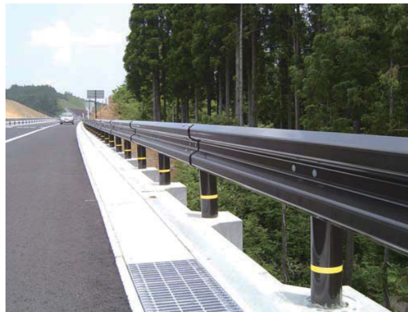
背面に側溝設置の事例
