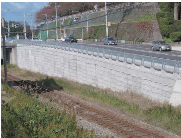
超軽量盛土直上設置の事例
