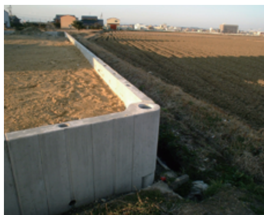
⑥設置完了
