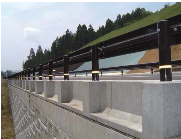
補強土壁直上設置の事例
