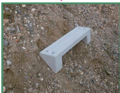
④打ち込み完了
