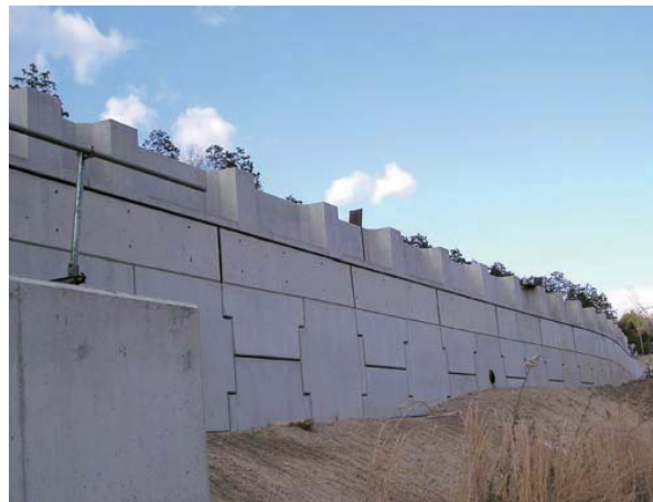
補強土壁直上設置の事例
