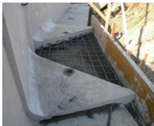
⑤底板現場打配筋状況
