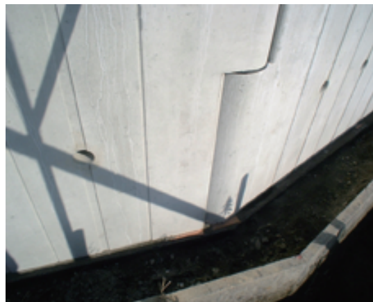
④接合部状況
