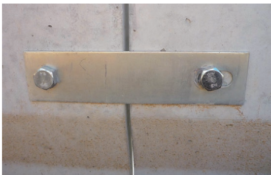
連結プレート取付状況
