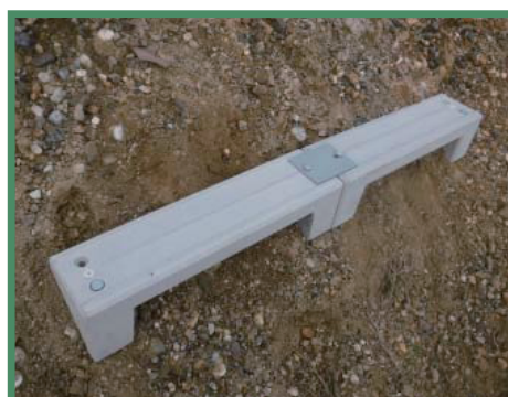
法面ステップ連結完了
