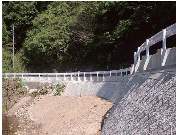
積ブロック直上設置の事例
